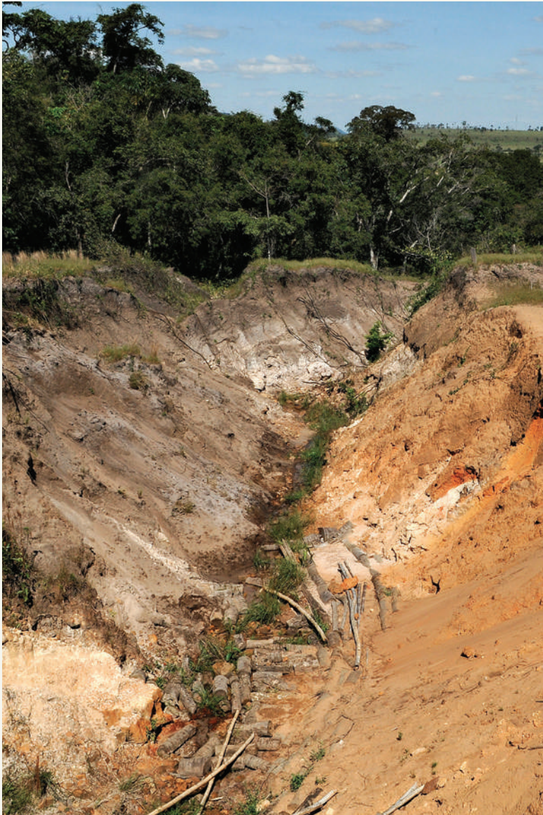
Parte da voçoroca da parede, antes da recuperação.
